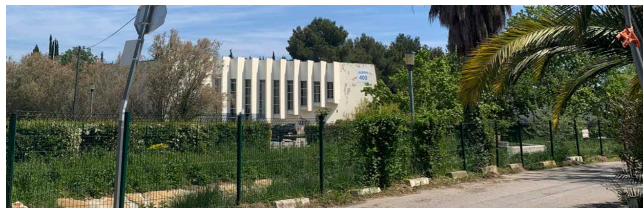
Etat actuel : un bâtiment plutôt enclavé et peu valorisé
