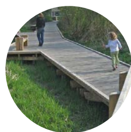
Passerelle bois surelevée
