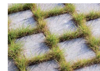
dalles béton armé semi-végétale / 40% de surface perméable
