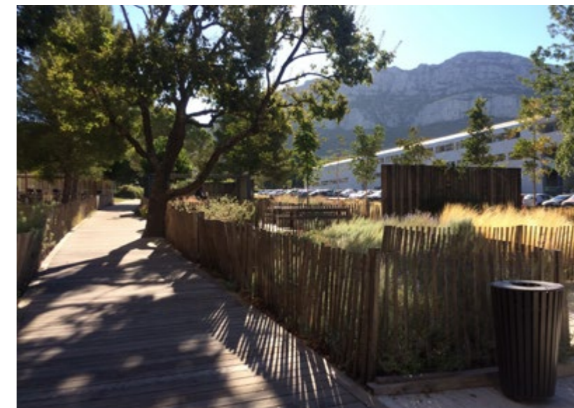
Sol en platelage bois - Protection des espaces sensibles par des ganivelles
